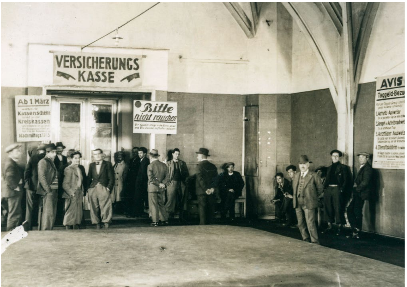
Caisse assurance – aide de crise ville de Zurich, salle d'attente du Helmhaus, 1936, photographe Edy Meyer, source: Archive sociale suisse, Zurich.
